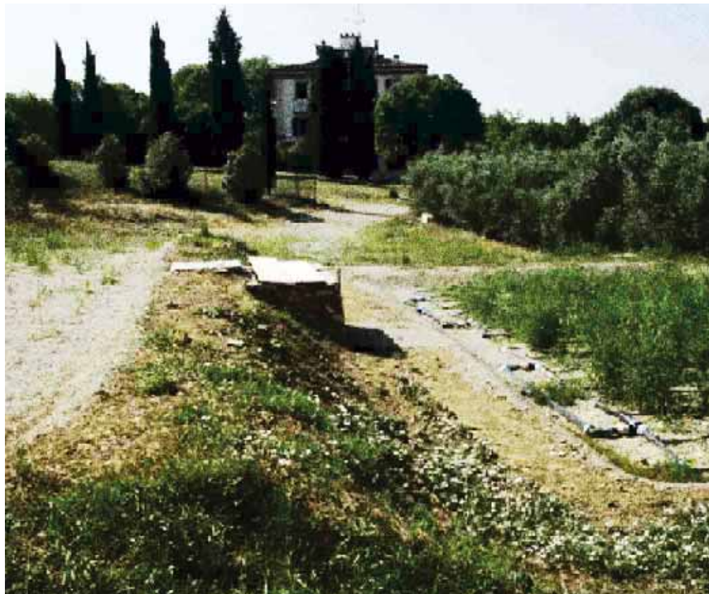
Características de un sistema multi-estadio compuesto por un sistema con flujo sumergido horizontal (a la derecha) y vertical (a la izquierda) al servicio de una estructura turística 140 A.E. (Firenze Italia)
